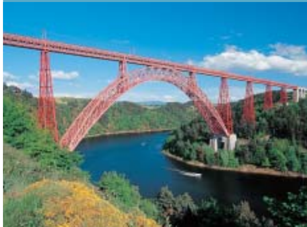
La plus connue des retenues de grands barrages est sans doute celle de Grandval, surplombée par le viaduc de Garabit.
