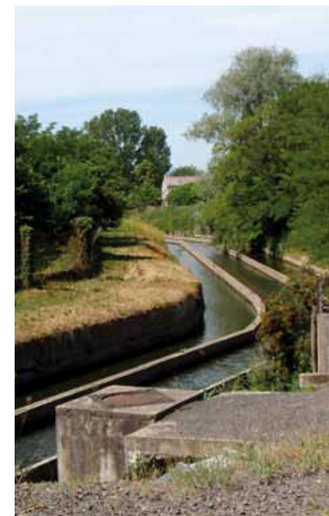
Jaze (63) - Canalisation sur le Bédard.
